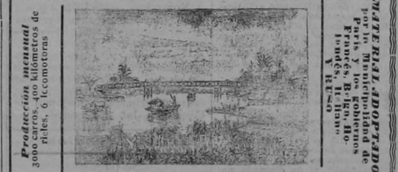
PUENTE DE 66 METROS EN DONG-NHYEN (Conchinchina) compuesto de 3 puentes de 22 metros, tipo 6 bis.
